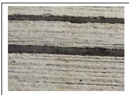
FIGURA 6.203.304.A EJEMPLOS DE CEPILLADO MÁS RANURADO LONGITUDINAL Y TRANSVERSAL
