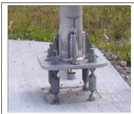
FIGURA 6.302.307.A EJEMPLO DE BASE DE POSTE COLAPSABLE CERTIFICADO
