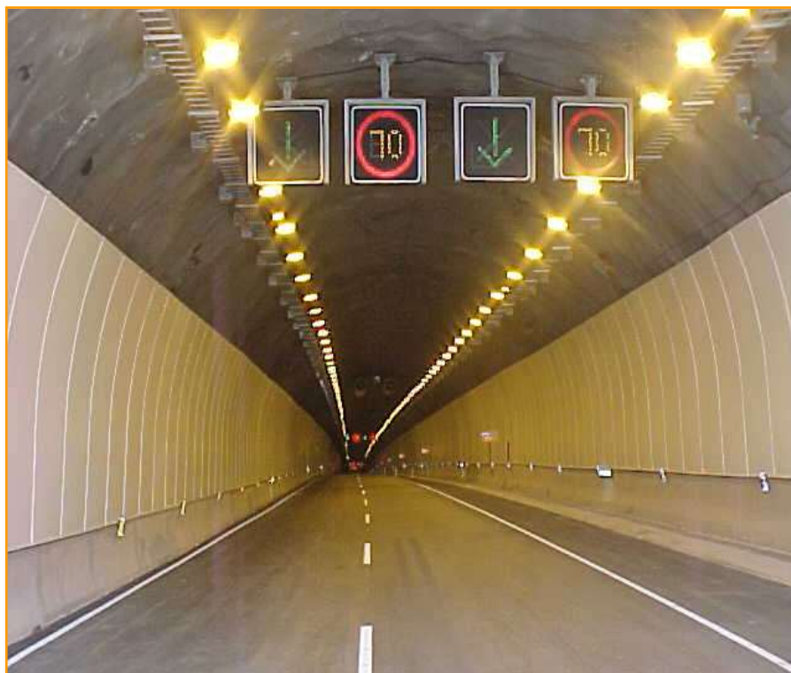
FIGURA 6.304.201.B EJEMPLO DE APLICACIÓN DE SEÑALIZACIÓN VARIABLE
